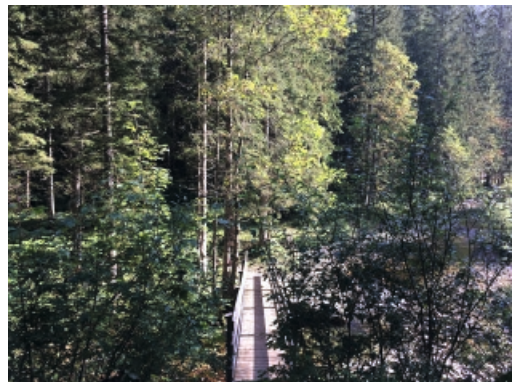
Abb. 62: Die Brücke zum Nagelsteig, September 2020 (Foto: Johannes Staudinger)
